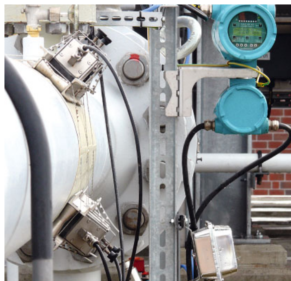
Bild 3. Sichere Messung im Ex-Bereich: Die Messumformer FLUXUS® G 800 sind ATEX-zertifiziert.
